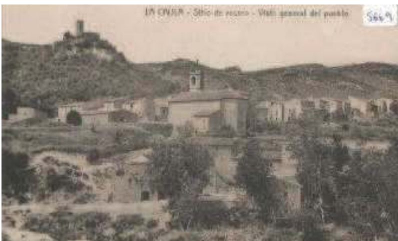
Vista general nord-est antiga
