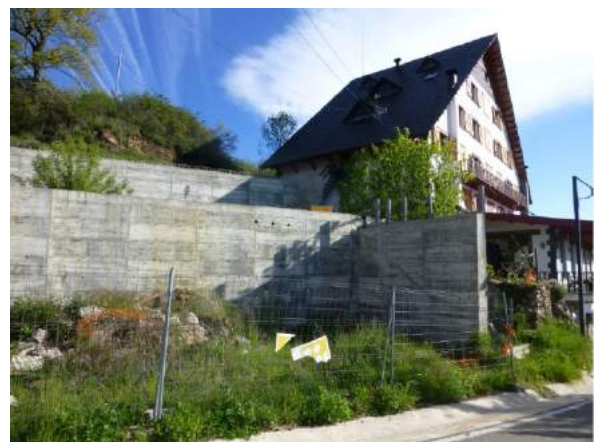
Fotografia anterior a l'enderroc dels murs de contenció
